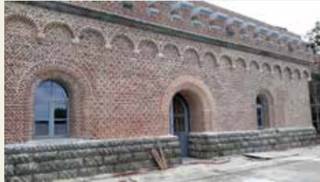
▲ De gerestaureerde voorgevel, vensters en kantelen.
